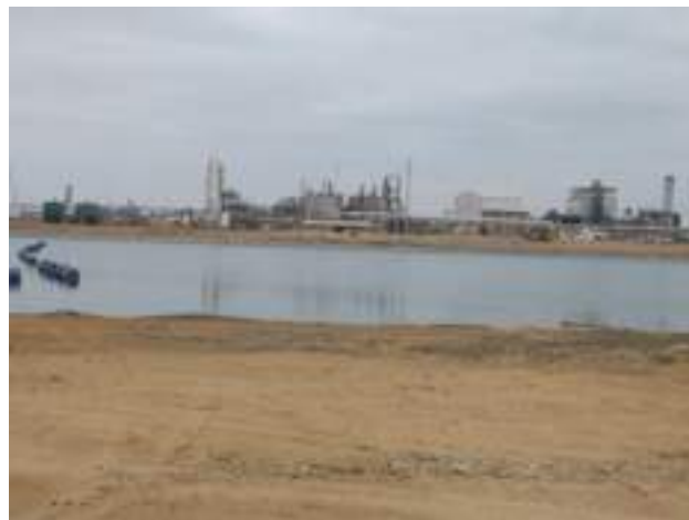
Un des quatre réservoirs de Maple, devant l'usine de transformation.
